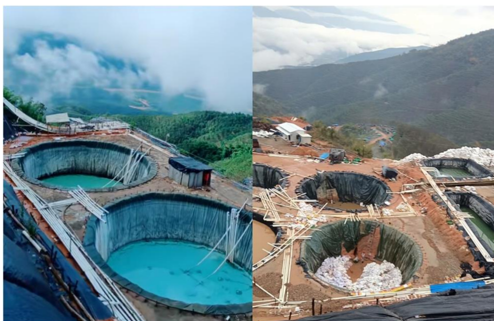
บ่อสารเคมีที่ใช้งาน
